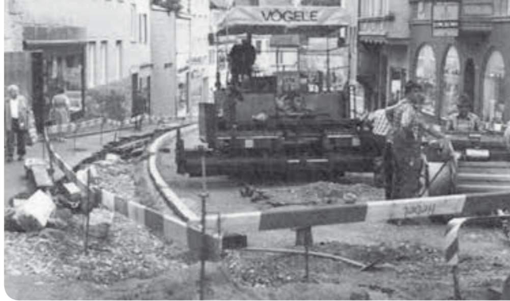
Den Umbau der Fahrbahn am Stadtberg Anfang der 80er Jahre nutzen die Stadtwerke für weitläufige Sanierungsarbeiten an Kabeln und Rohren. Auch neue Straßenbeleuchtungskörper wurden aufgestellt.
